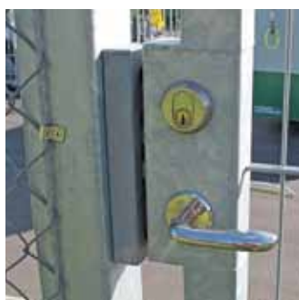
Lågen leveres med låsekasse og standard cylinder.
